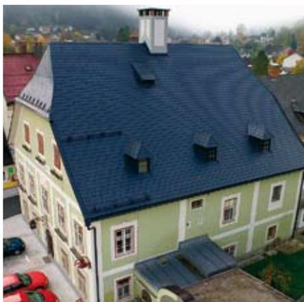
прочным на сегодняшний день покрытием (PP 99). Все компоненты кровли, включая элементы отделки, элементы безопасности и водосточные системы, сделаны из одного материала и в одной цветовой гамме.
